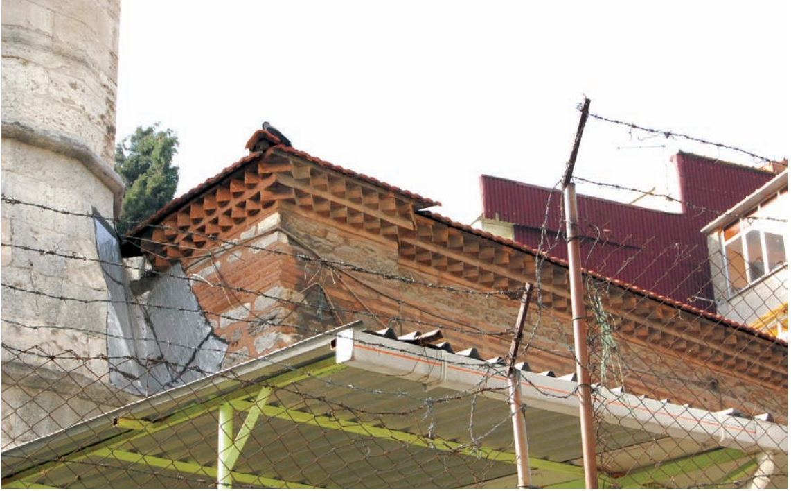
Resim 13. İki sıra kirpi saçak düzeni, minare yapı bütünleşmesi (M.Sav,2008)
