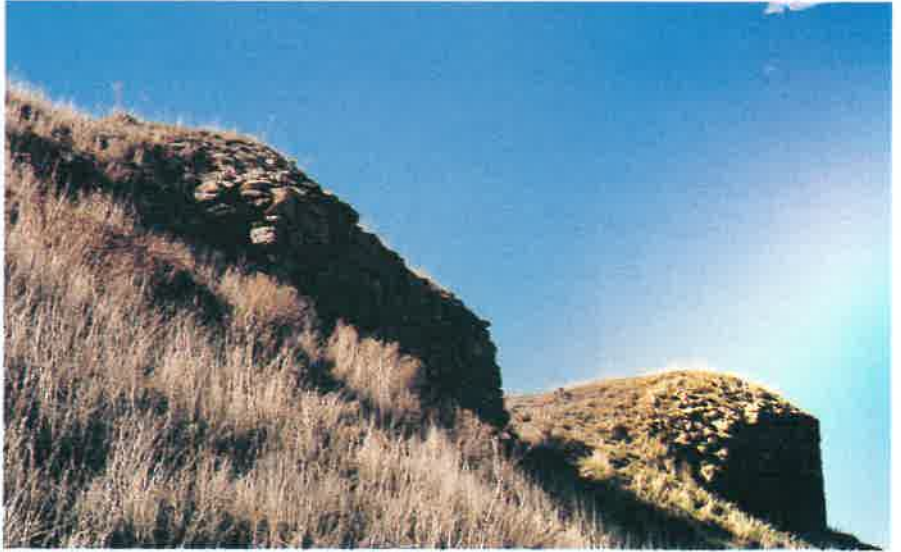
Resim 11: Pertek Kalesi kuzey dış surlar kuzey cephe.
