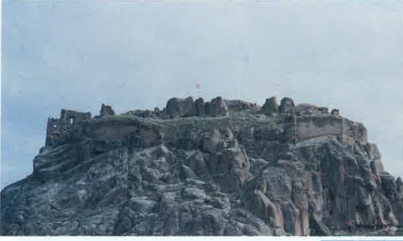
Resim 19: Pertek Kalesi güney surlar.
