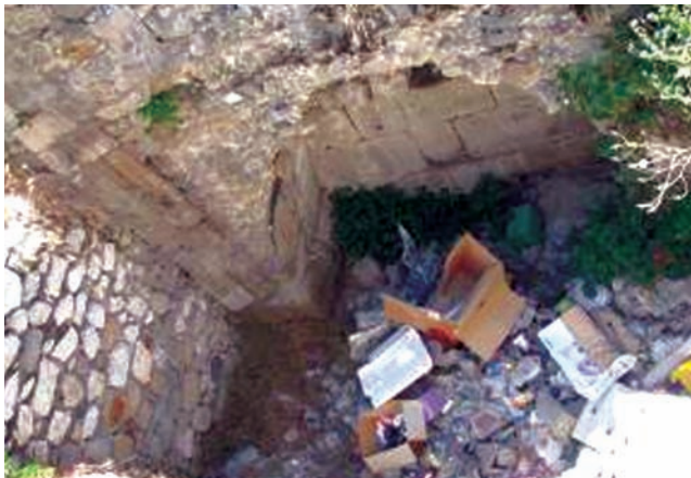
Resim-4: Kuzey cephesinin kazı öncesi görünümü (26 Haziran 2012)
