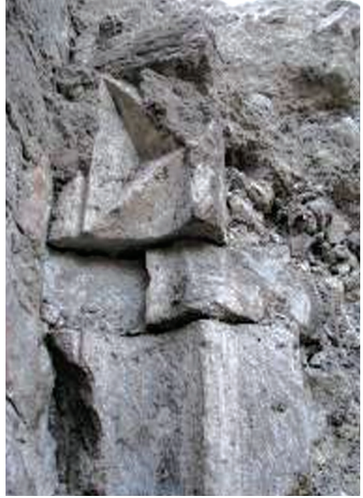
Resim-8: Güney cephesi süsleme detayı
