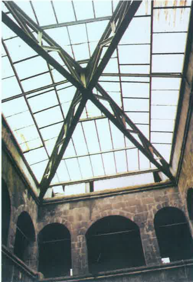
Fotoğraf 10: Hakkâri Meydan Medresesi Sonradan İnşa Edilmiş Örtü Görünüşü.
