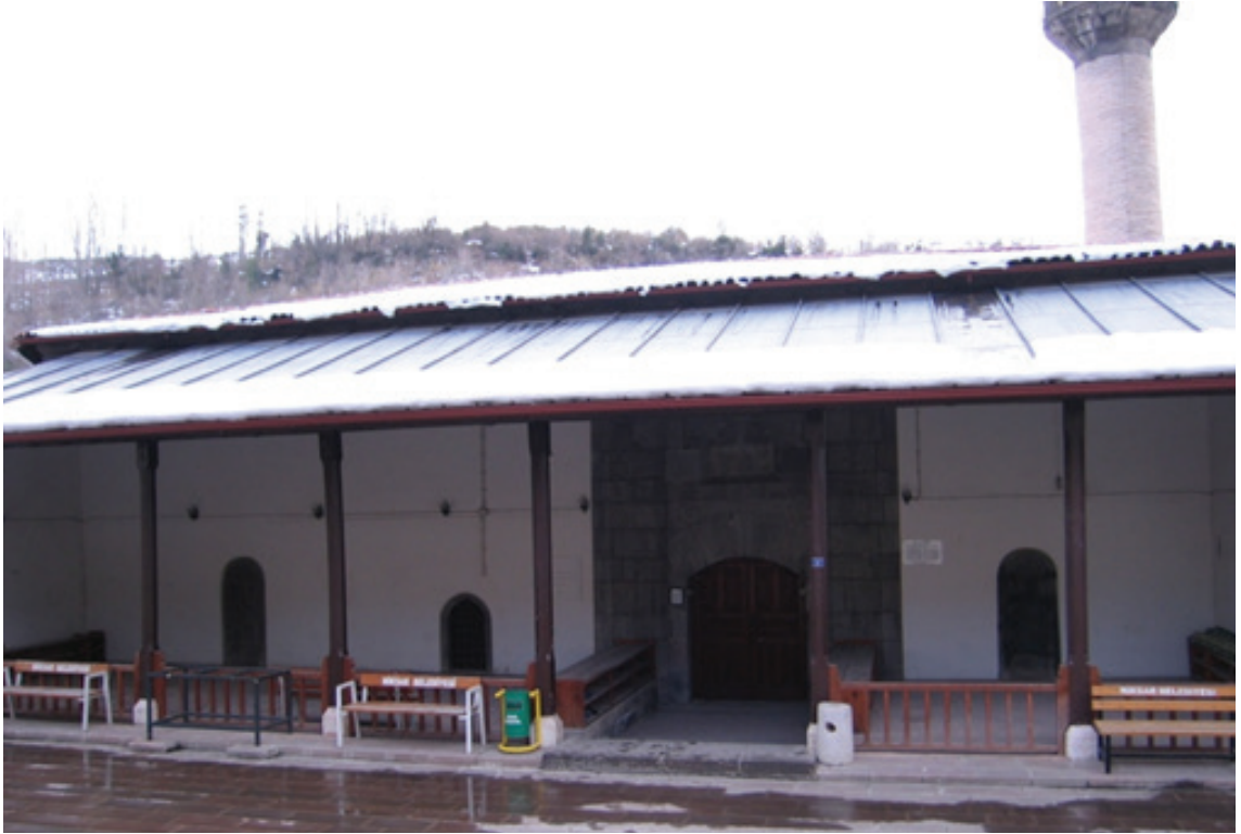
Resim 2. Ulu Camii'nin kuzey cephesi (2012)
