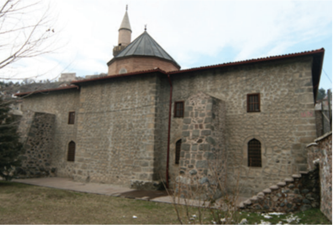
Resim 10. Yapının güney cephesi (2012)
