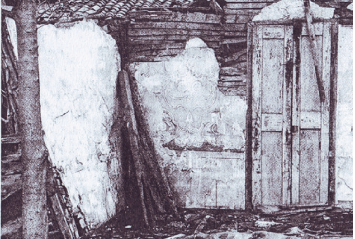
Resim 4.Kazlıçeşme Tekkesinin Restorasyon Öncesi Hali (1994) (Tanman 1997: 118).
