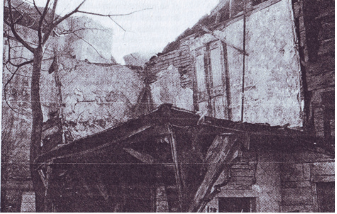
Resim 3.Kazlıçeşme Tekkesinin Restorasyon Öncesi Hali (1994) (Tanman 1997: 118).
