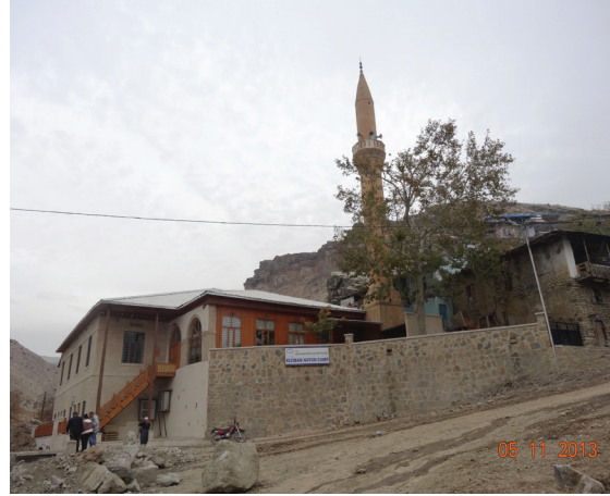
Resim 2. Çağlayancerit Kezban Hatun Camiinden Bir Görünüş.
