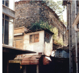
Resim 6. Güneybatı cephesi (Trabzon, K.V.K.K. Arş.)
