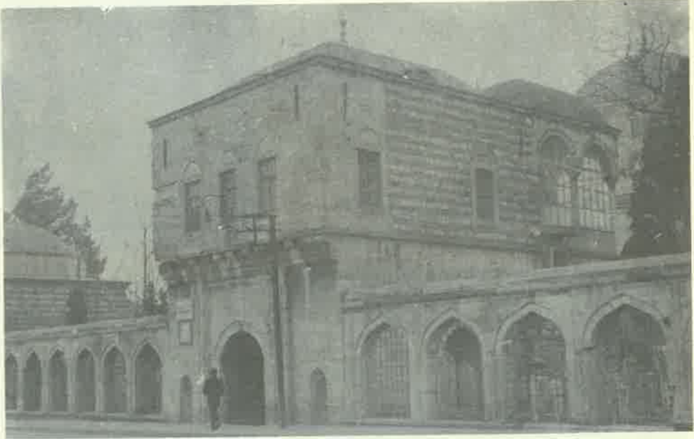
RESİM : 2 Hekimoğlu Ali Paşa Kütüphanesi'nin ön görünüşü
