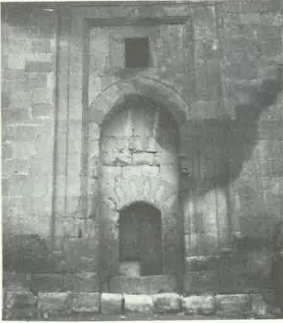
FOTO:7 Kayseri Köşk Medrese, onarım sonrası giriş kapısı detay
