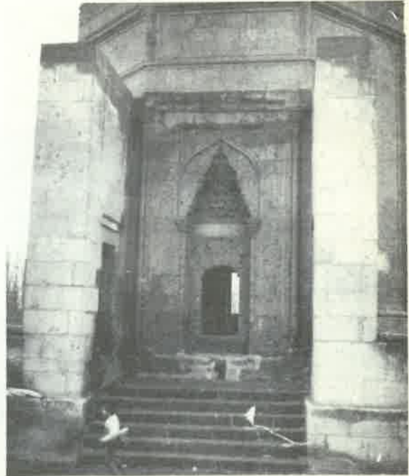
FOTO:10 Kayseri Ali Cafer Kümbeti, onarım sonrası, kuzey (giriş) cephesi ve ön giriş mekanının yeniden düzenlenen görünüşü (1984)
