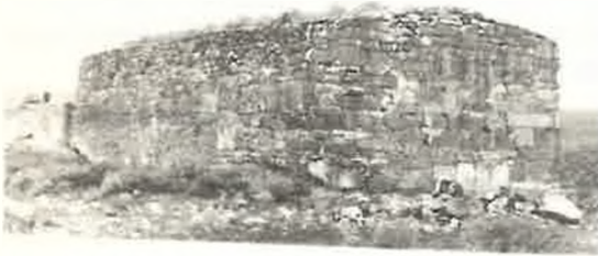
RESİM: 3 Melegazi Türbesi, kuzey ve batı cepheler
