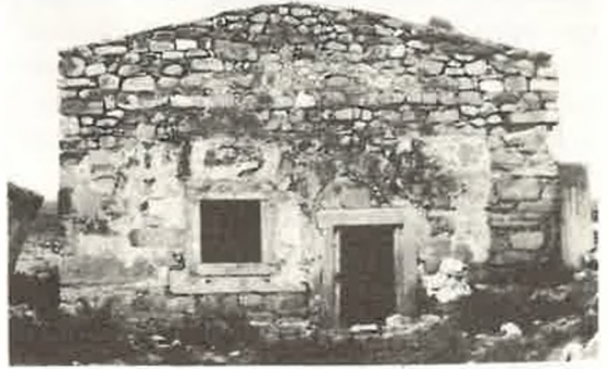
RESİM: 2 Melegazi Türbesi doğu cephe
