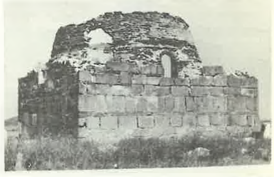
RESİM: 8 Yılankiran Türbesi batı cephesi
