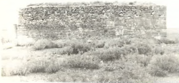
RESİM: 5 Melegazi Türbesi kuzey cephesi
