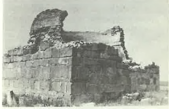
RESİM: 10 Yılankiran cTürbesi güney ve batı cepheler
