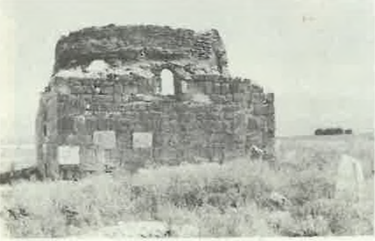
RESİM: 9 Yılankiran Türbesi kuzey cephesi
