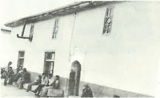
RESİM: 3 Bayındır Camii'nin doğu cephesi ve girişi
