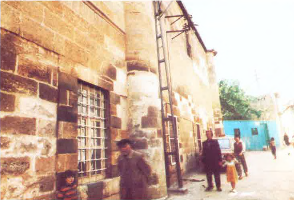
RESİM: 12 Camlın batı duvarı ve bu duvarı destekleyen payandaların görünüşü
