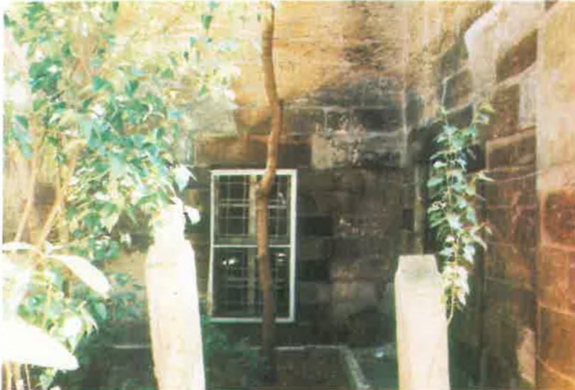
RESİM: 10 Pencerelerin dıştan görünüşü
