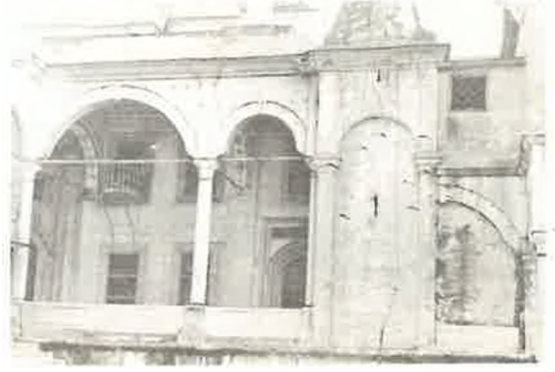
RESİM: 22 Selimiye Camii kuzey cephesi
