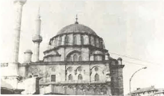
RESİM: 13 Laleli Camii genel görünüş - 1984
