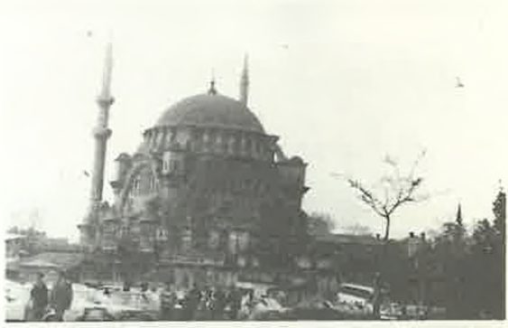
RESİM: 5 Nur-u Osmaniye Camii Genel Görünüşü - 1984
