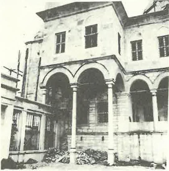
RESİM: 18 Beylerbeyi Camii kuzey cephesi - 1970
