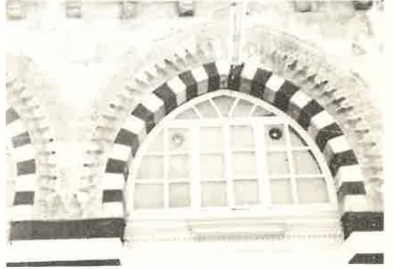
RESİM: 7 Harım cephesindeki kemerlerden detay
