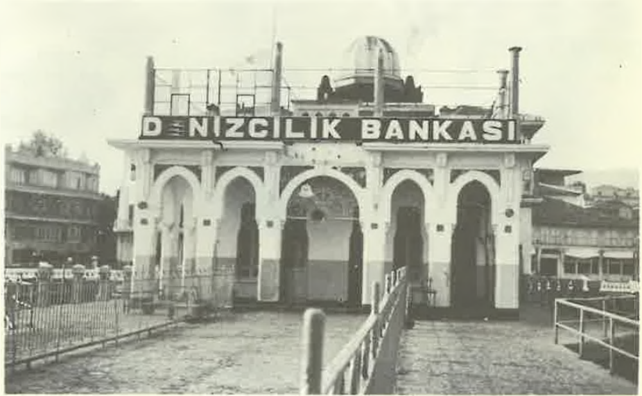
FOTO: 5 Büyükkada Iskele binasının deniz cephesinden görünüşü
