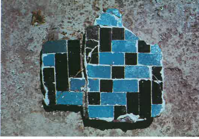
Res. 8: Doğu kanat kuzeyindeki köşe odada duvar çini kaplama döküntüleri.
