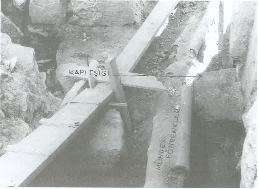
Res. 6: Islak alan kapı eşığı üstündeki muhdes pöhrenkler ve solda üst kat merdiven kapı eşığı.
