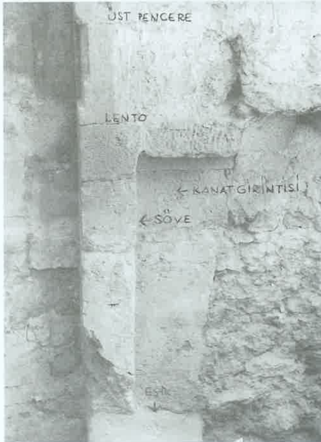
Res. 5: Islak alan kapısının, eşik, sol söve, lento kökü ve üst pencere kalıntısı.
