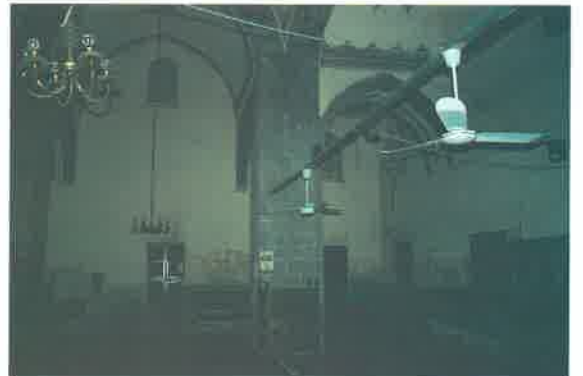
Res. 30: Diyarbakır Merkez Safa Camii iç görünüş (1991).
