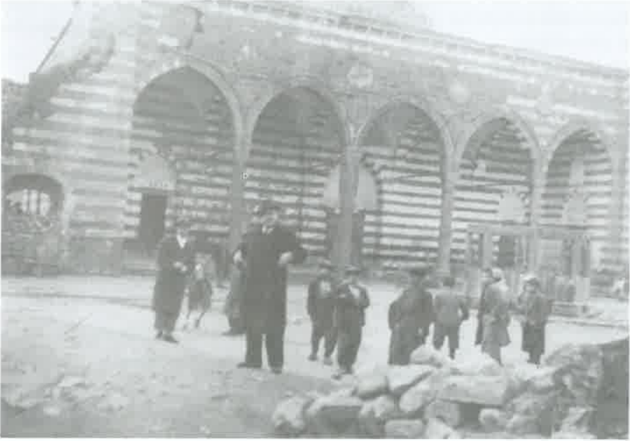
Res. 3: Diyarbakır Merkez Safa Camii kuzey cephesi ve son cemaat yeri (1965).
