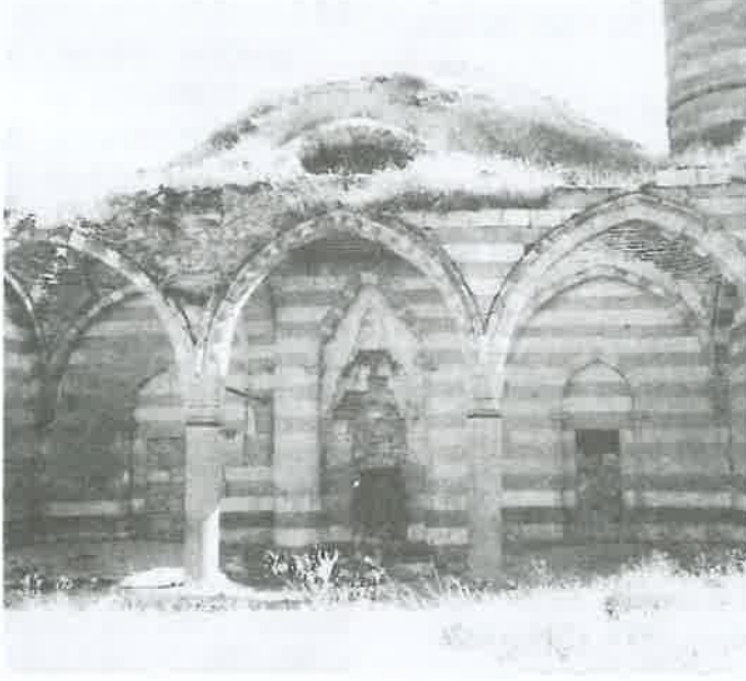
Res.1: Pertek, Baysungur Camii. Kuzey cephe taşınmadan önceki durumu (VGM Arşivi).
