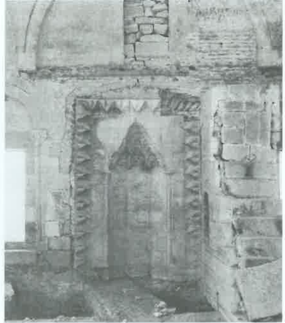
Res.10: Pertek, Baysungur Camii. Mihrabın taşınmadan önceki durumu (VGM Arşivi).
