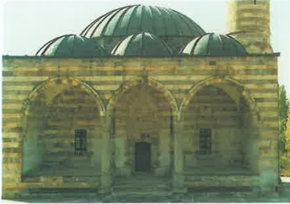
Res.2: Pertek, Baysungur Camii, kuzey cephe.
