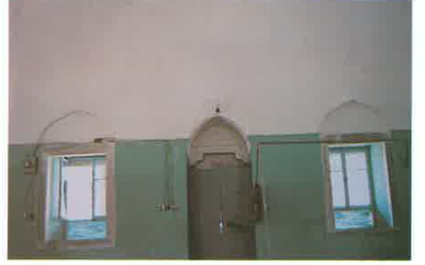
Res.18: İç Mekandan, kuzey duvarı.
