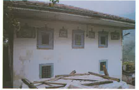
Res.4: Caminin kible duvarı ve çatısı.
