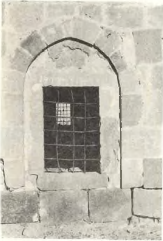
RESİM: 4 Mescid'in batı cephesindeki pencere
