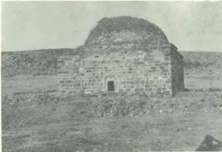
RESİM:1 Yağmapınarı Mescidi'nin çaktan görünüşü.
