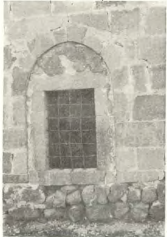
RESİM: 5 Mescid'in doğu cephesindeki pencere
