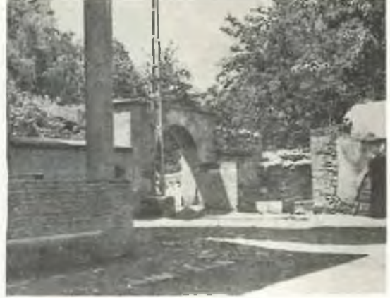
RESİM : 3 Camii avlu duvarı, güney girişi kapısı.
