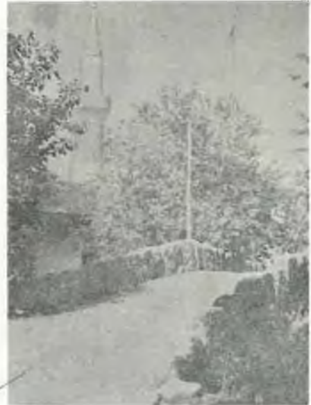
RESİM: 10 Karlıova'da bir köprü.
